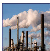
Traitement de l'air
