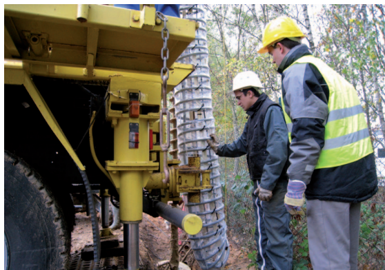
Mise en place d'un échangeur géothermique compact de 10 m de hauteur et 400 mm de diamètre sur la plateforme expérimentale du BRGM à Orléans dans le cadre du projet ANR-ECLIPSE. (photo BRGM).
